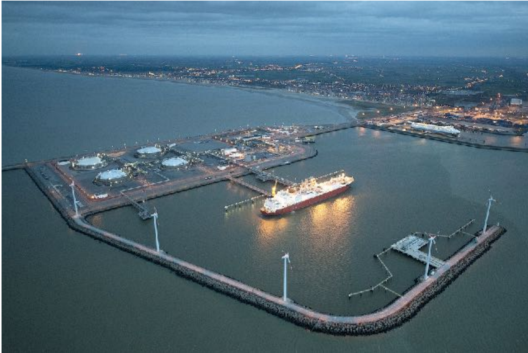
The LNG terminal in Zeebrugge.
